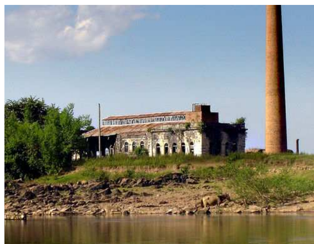
FIGURA 3 - Usina de Itaicy, Santo Antônio de Leverger - MT
