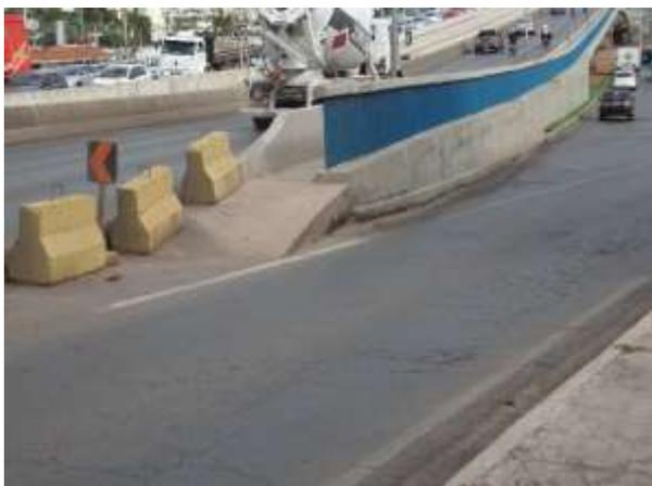
**Figura 06 - Ausência de faixa de pedestre no início das rampas do viaduto**
